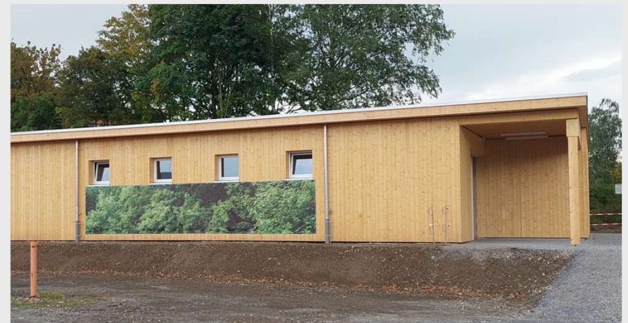
Schäflerstrasse 3 (Pavillon) Abteilung Rot
