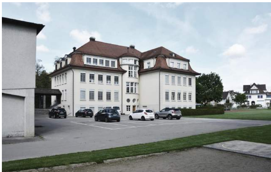
Interner Parkplatz südlich TBS1
