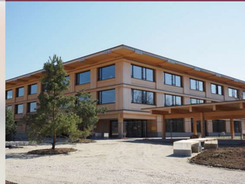
Martin Haffter Schulzentrum
